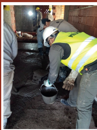
Figura 3: Extracción de muestra en obra a la salida de la bomba, después de descartar 0,75 m 3 iniciales y antes de 0,75 m 3 finales del camión.
