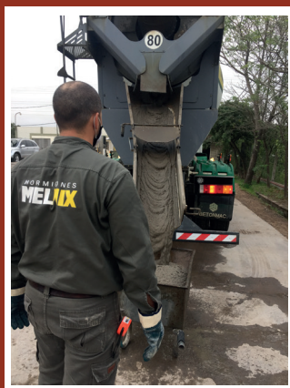
Figura 2: Extracción de muestra desde el motohormigonero, después de descargar 0,75 m 3 iniciales y antes de 0,75 m 3 finales del camión.
