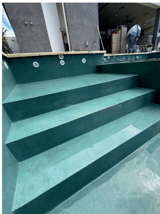
^ Vista de revestimiento cementicio coloreado en masa; es muy utilizado en piscinas.
