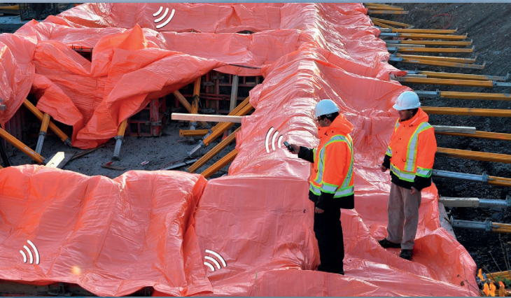
F3: Protección y control de temperaturas (fotografía gentileza de Giatec Scientific).
