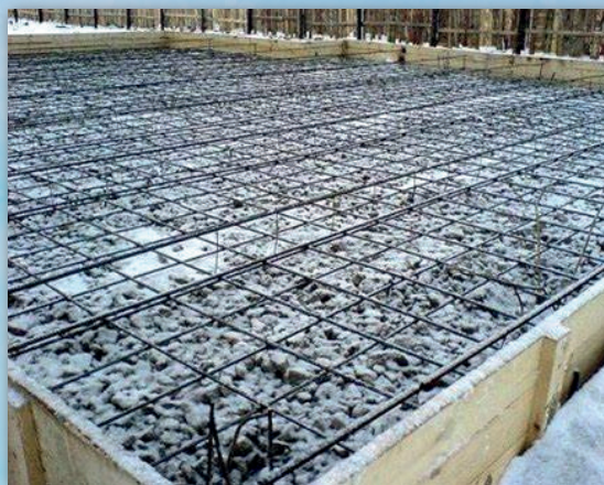
F4: Antes del hormigonado se debe comprobar que los encofrados, armaduras y lugares que ocupará el hormigón estén libres de nieve, hielo o escarcha.
