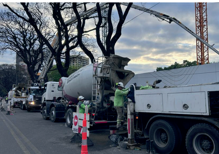
Coordinación y control del movimiento de los vehículos en la calle (obra de AGH).
