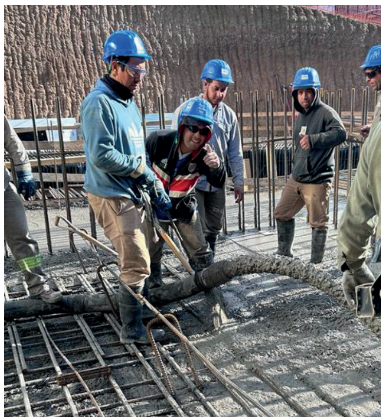
^ Bombeo de hormigón en obra de AGH.
