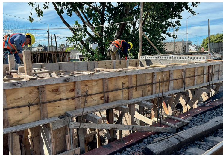
Operarios en obra de Pose.
