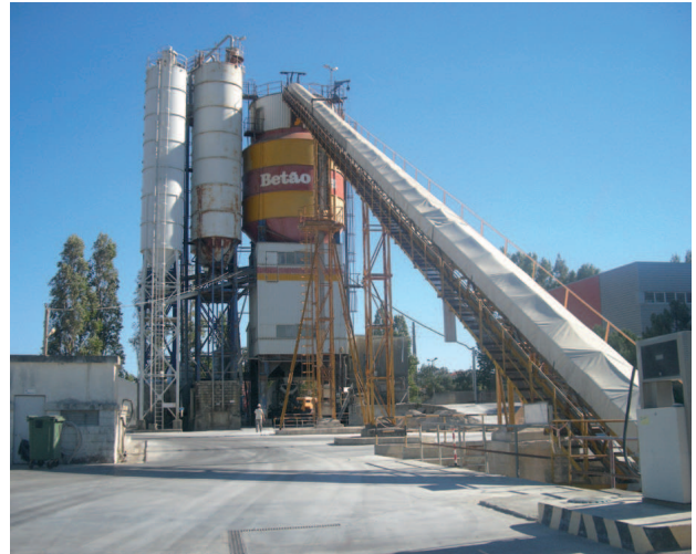
▲ F. 5 Cintas transportadoras con cobertura de lona
