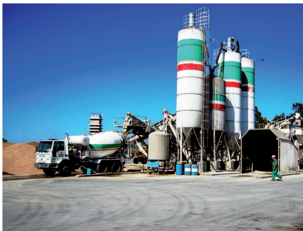
▲ F. 8 Piso impermeable en toda la planta
