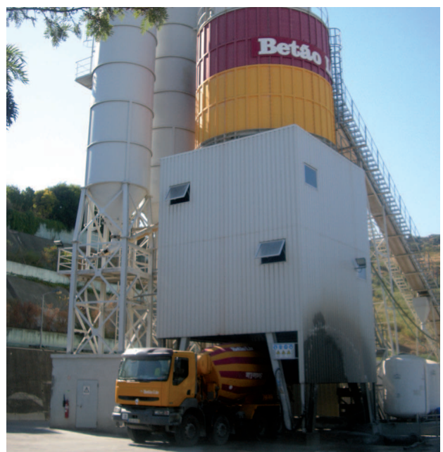
▲ F. 6 bis Vista exterior de Box de carga con cortina
