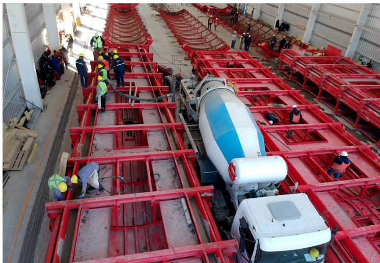
Colado del hormigón con *mixers* en Allen. Allí se fabricaron las dovelas de hormigón para las torres del parque eólico Vientos Neuquinos.
