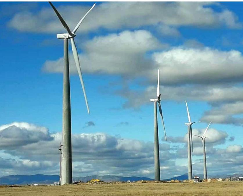
LA EMPRESA PREAR FABRICÓ 1.298 DOVELAS DE HORMIGÓN PRETENSADO PARA CONSTRUIR 59 TORRES DE AEROGENERADORES QUE SE INSTALARON EN DOS PARQUES EÓLICOS, UNO EN BAHÍA BLANCA Y OTRO EN NEUQUÉN. SON DE HORMIGÓN H-60 AUTOCOMPACTANTE. CADA TORRE DEMANDÓ APROXIMADAMENTE 430 M<sup>3</sup> DE HORMIGÓN (25.000 M<sup>3</sup> EN TOTAL).
