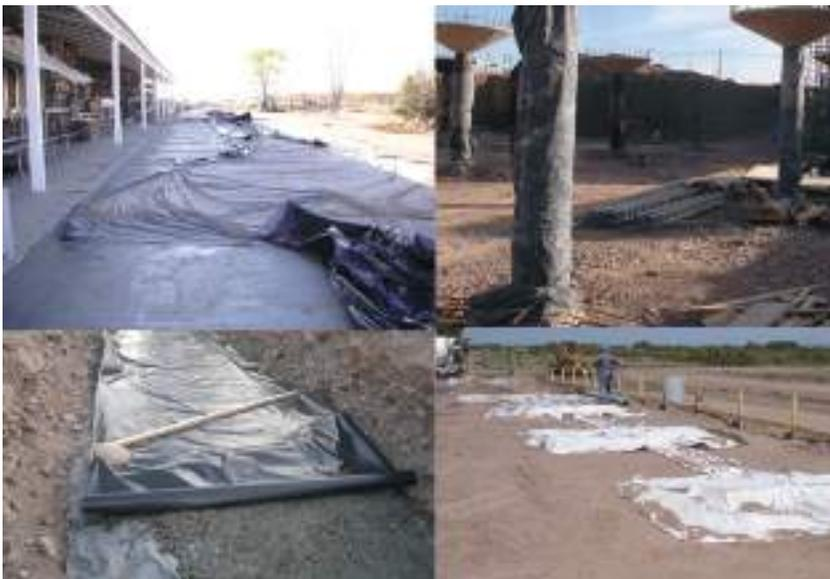
◀ F3 – Láminas plásticas para el curado del hormigón ▶
