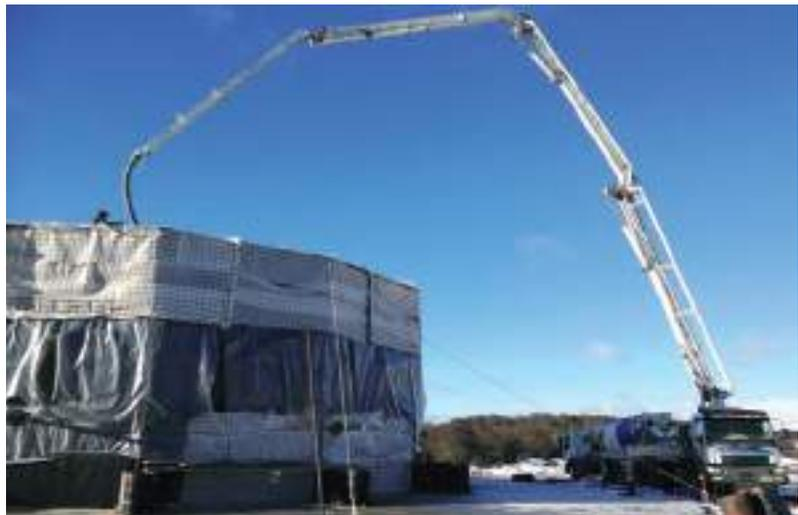
protección y generación de calor con equipos con diversos combustibles. Las bases de la antena principal llevan aproximadamente 800 m<sup>3</sup> de H30, colocados por bombeo, en tiempo frío.
