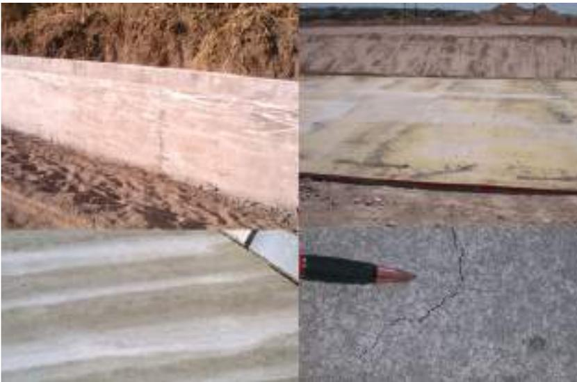
◀ F5 – Incorrecta aplicación de membranas de curado
